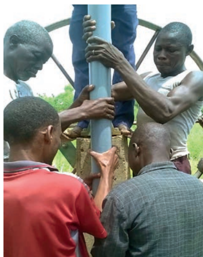
La réparation de la pompe
