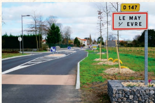
Aménagement de la route de Bégrolles-en-Mauges.
