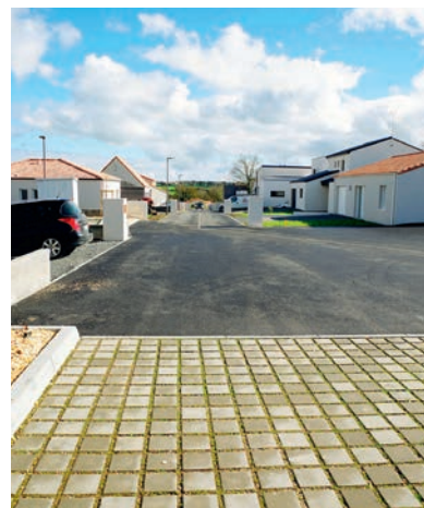
La voirie est maintenant effectuée dans les rues Simone Veil et Germaine Tillion
