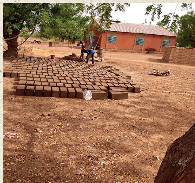
Les briques sont moulées une à une et séchées au soleil
