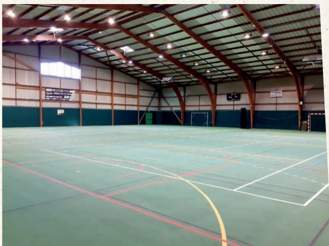
Travaux salles de sports (salle 2 avant et après)
