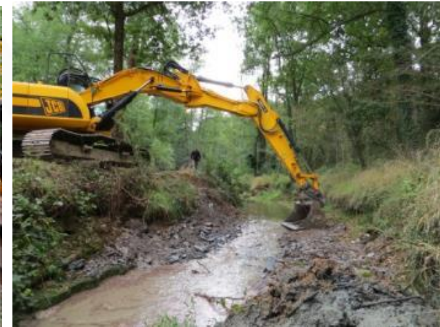
Recharge granulométrique et aménagement de banquettes
