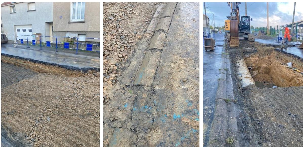
Sur la partie ancienne, il y a très peu de pierre, donc la rue n'est pas adaptée au passage des camions et des tracteurs mais elle tient encore. Quand les travaux sont faits, ils remettent 45 cm de pierre compactés. Un contrôle est fait au niveau du compactage.
